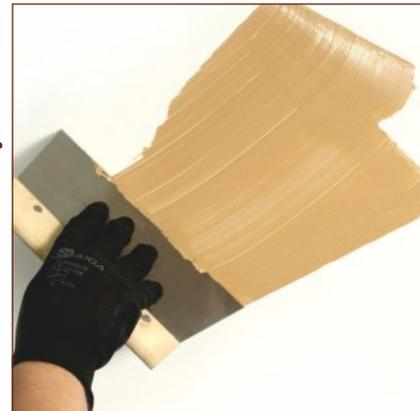
1. Нанесите клей равномерным слоем металлическим зазубренным шпателем – гребенкой 2/4 мм.
