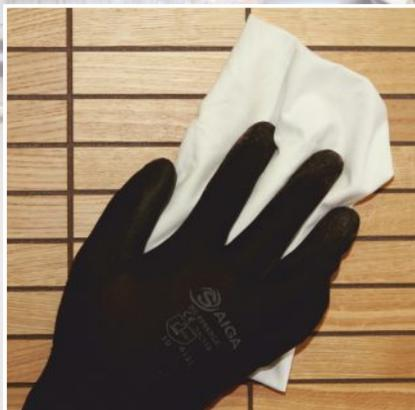
6. После высыхания шпаклевки удалите грязь и отшлифуйте поверхность тряпочкой, смоченной в жидкости „FugaSoap“.
