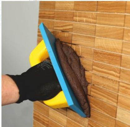
3. Шпаклевку наносите снизу вверх, поперек швам.
